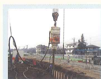
矢板規格：SP-III型 (L=10.5m) 発注：国土交通省 工事名：日野共同溝工事
