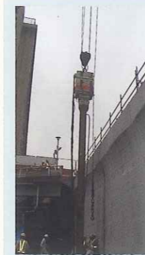
杭規格：H400×400 (L=16m) 発注：JR東日本 工事名：品川駅ハツ山アンダーパス新設
