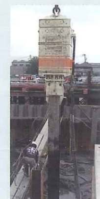
杭規格：H400×400 (L=32m引抜き) 発注：広島市 工事名：平和橋(仮称)架替工事
