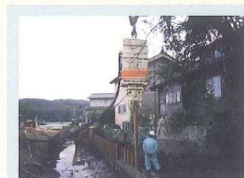
矢板規格：SP-II型 (L=8m) 発注：石川県 工事名：大谷川広域基幹河川改修工事
