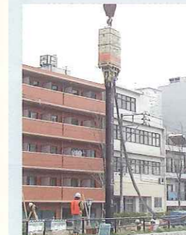
杭規格：H300×300 (L=28.5m) 発注：広島市 工事名：明治橋仮歩道橋設置工事
