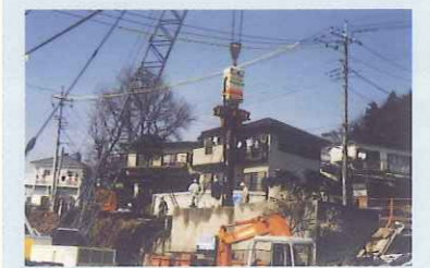
杭規格：φ500×15m 発注：東京都 工事名：道路改修工事及び補償代打工事
