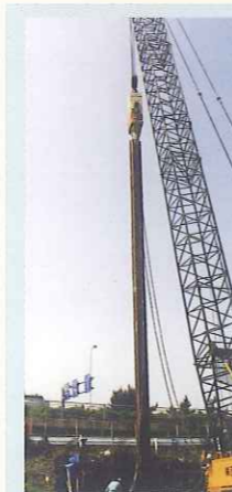
杭規格：H350×350 (L=34m) 発注：横浜市 工事名：坂下橋架替工事
