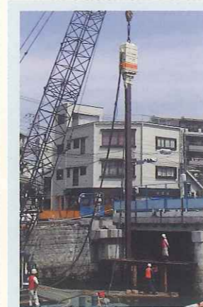
杭規格：H350×350 (L=34m) 発注：横浜市 工事名：坂下橋架替工事
